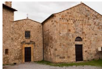
Facciata della chiesa San Michele in Rencine
